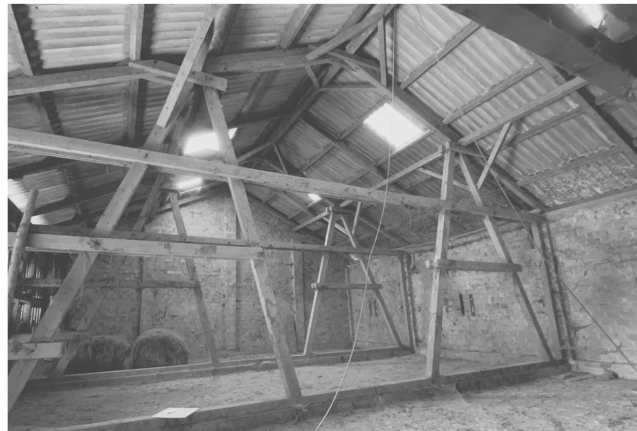
Vues sur la structure existante de l'étage - Trame des fermes de charpentes
